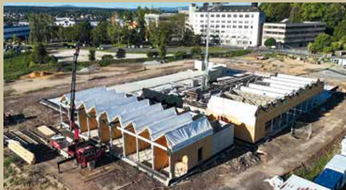
Aktuelle Drohnenaufnahmen zeigen den Baufortschritt des Designstudios Selb. Die Kubatur des nördlichen Studios und der östlichen Werkstätten ist bereits deutlich erkennbar
