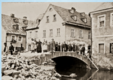
Stavba Selbského mostu, ulice Hohenbergerstraße v roce 1921
