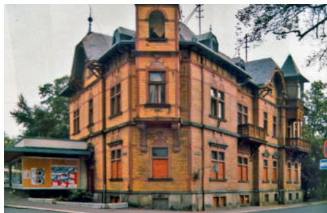
Ploßova vila krátce před demolicí
